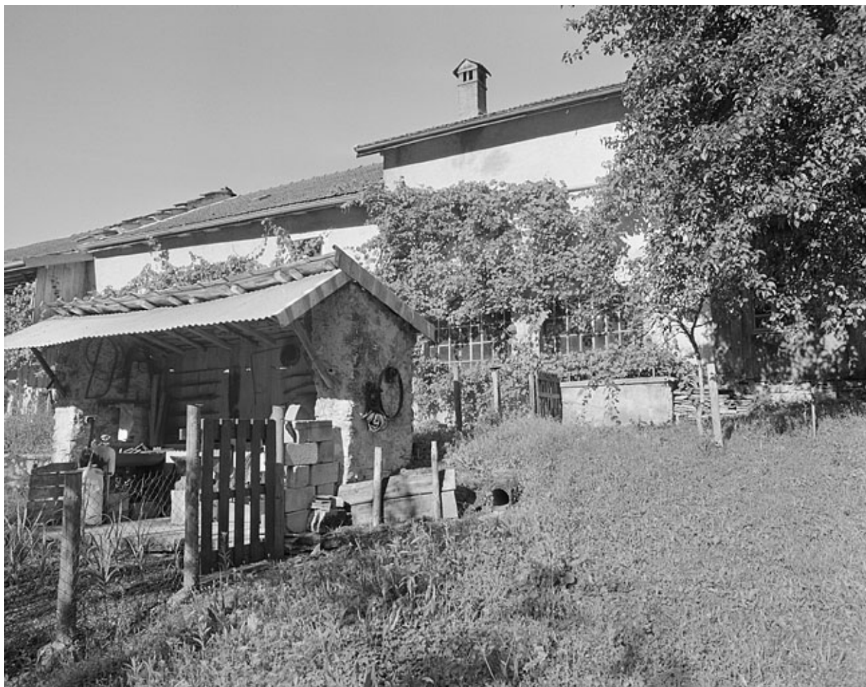
Façade postérieure de l'atelier.
