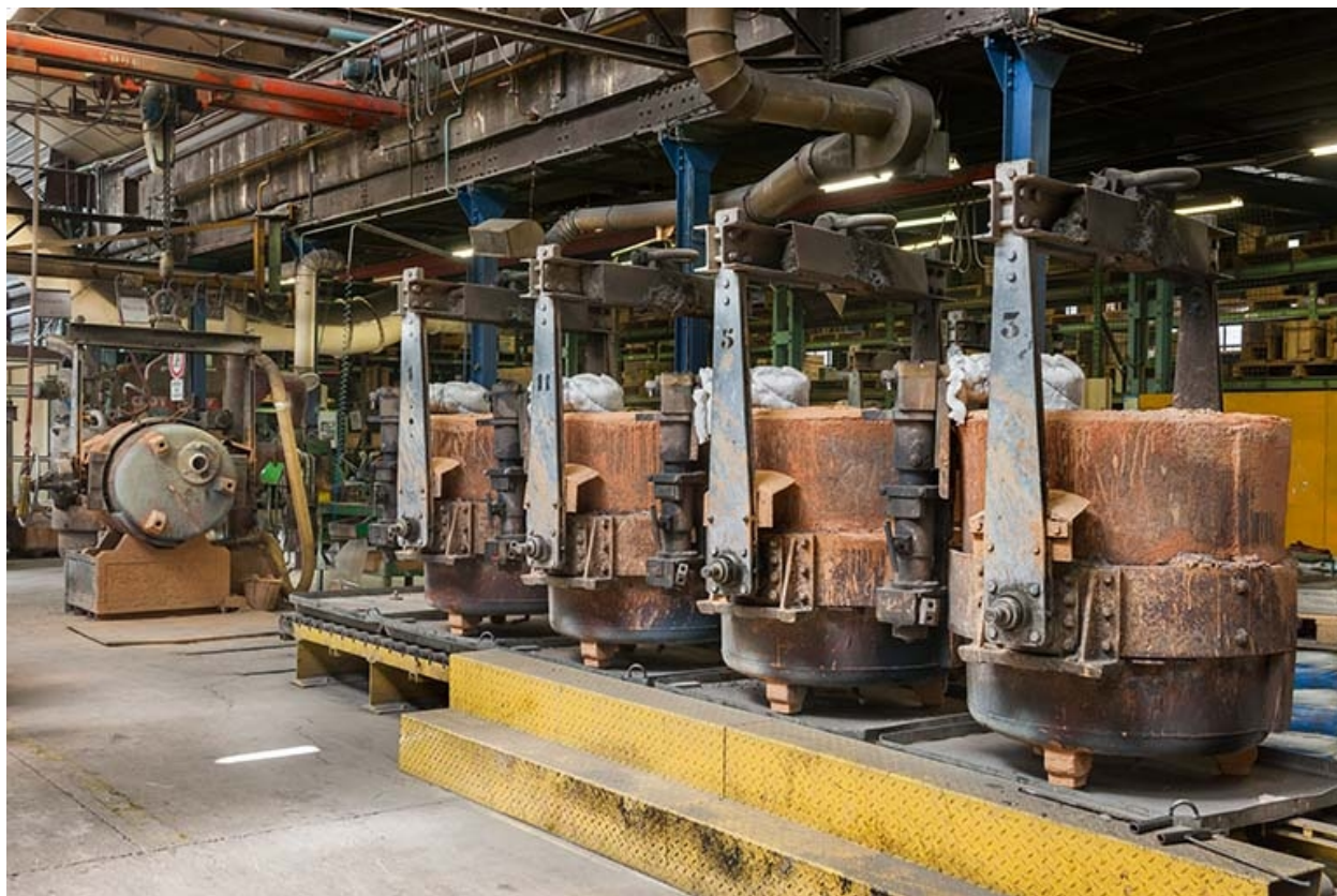
Poches de coulée avant réfection (1).
