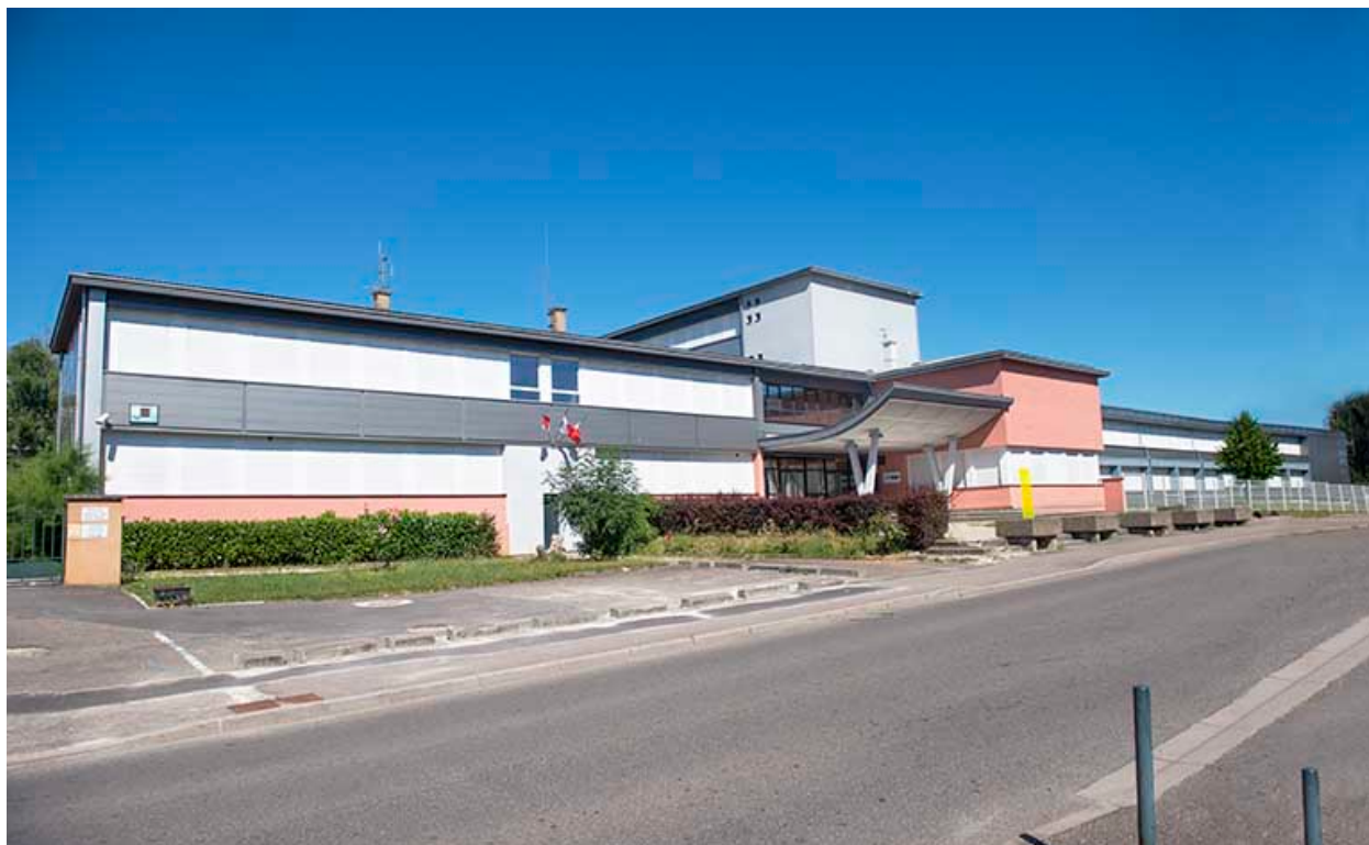
Façade antérieure sur rue.
