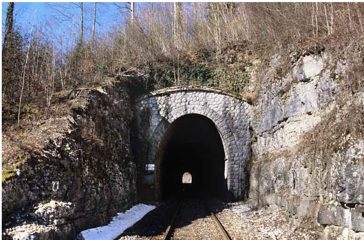
Tunnel des Bataillards : tête côté Andelot-en-Montagne (est).
