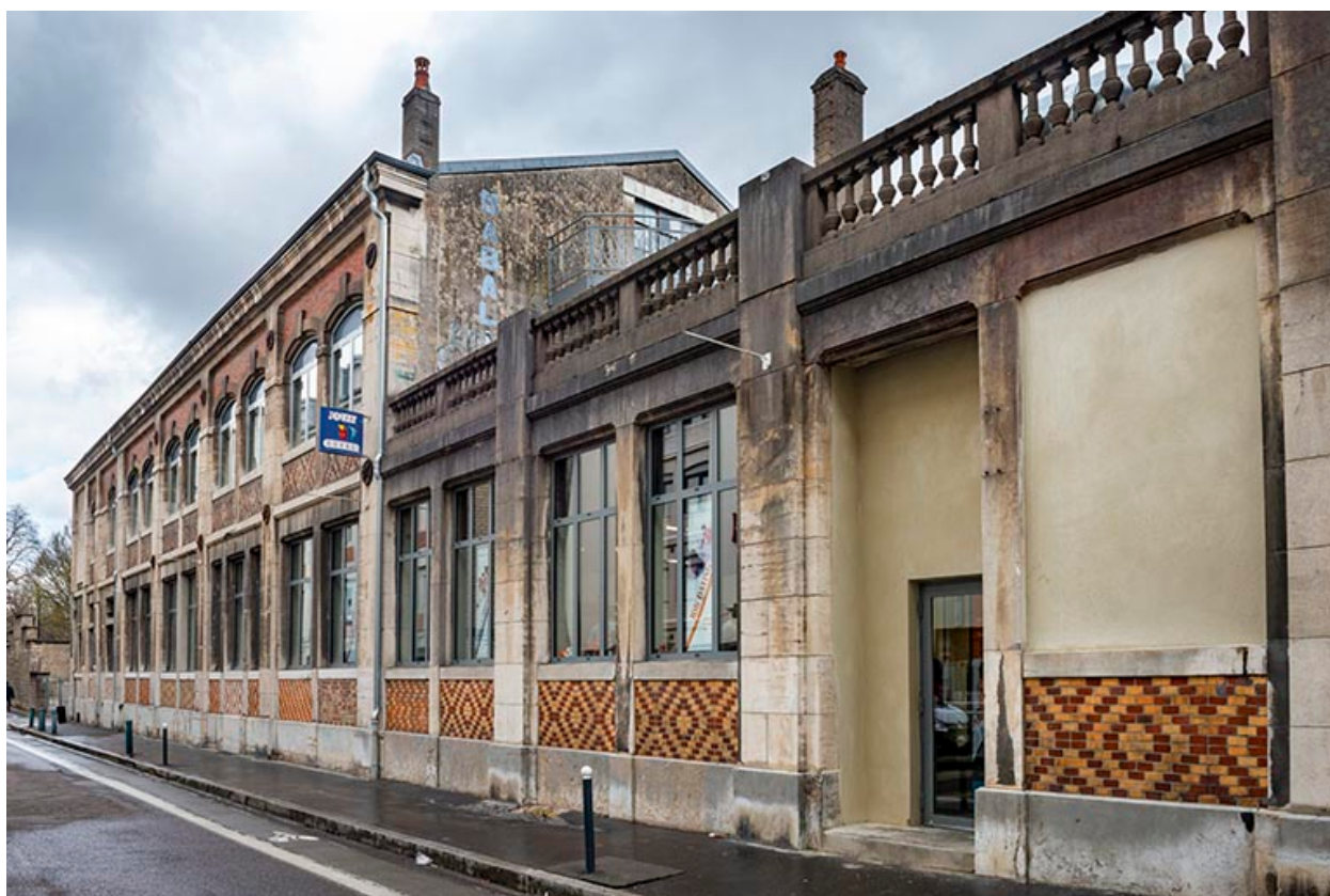
Vue rapprochée depuis le sud-ouest (après travaux).
