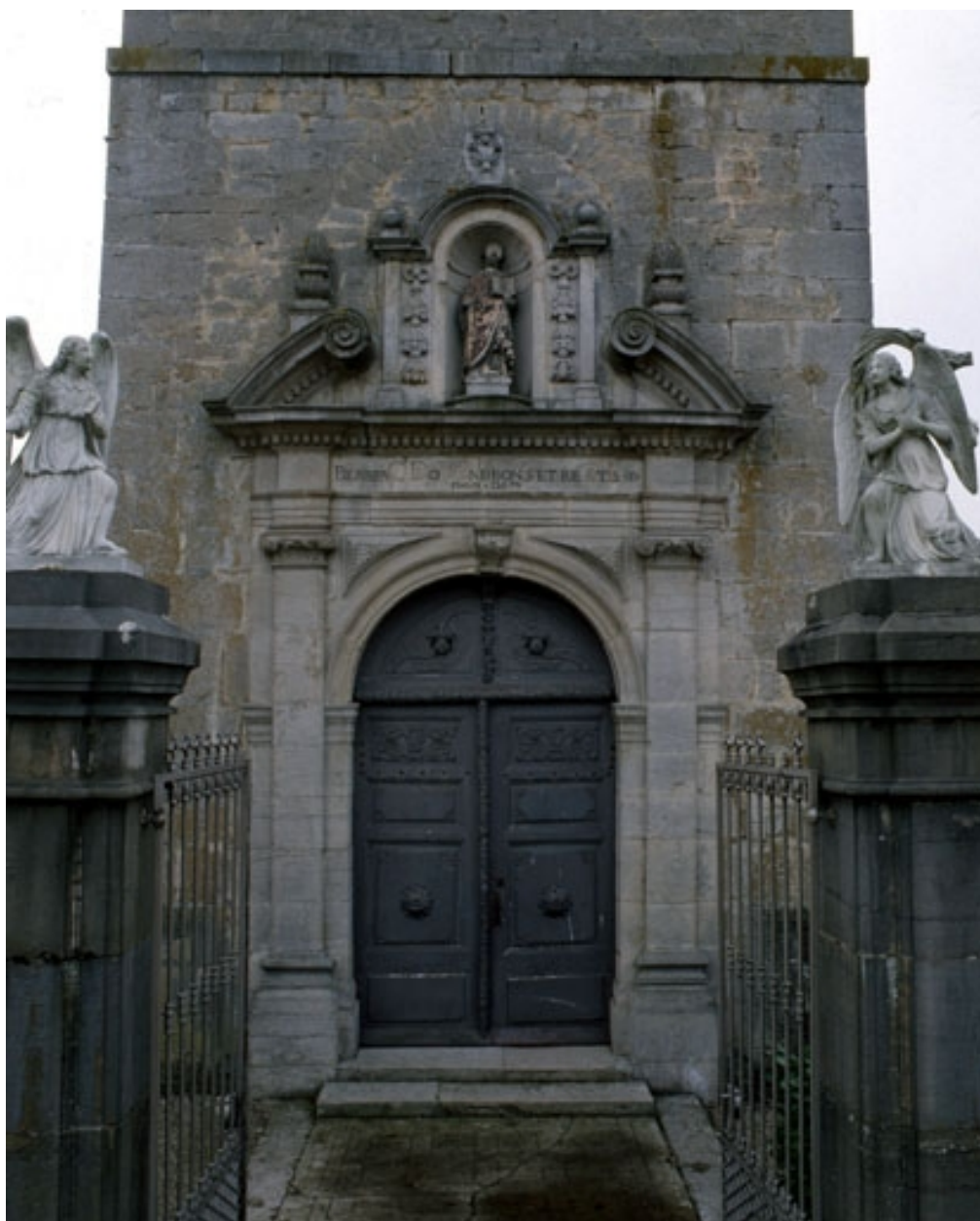
Portail et grille d'entrée.
