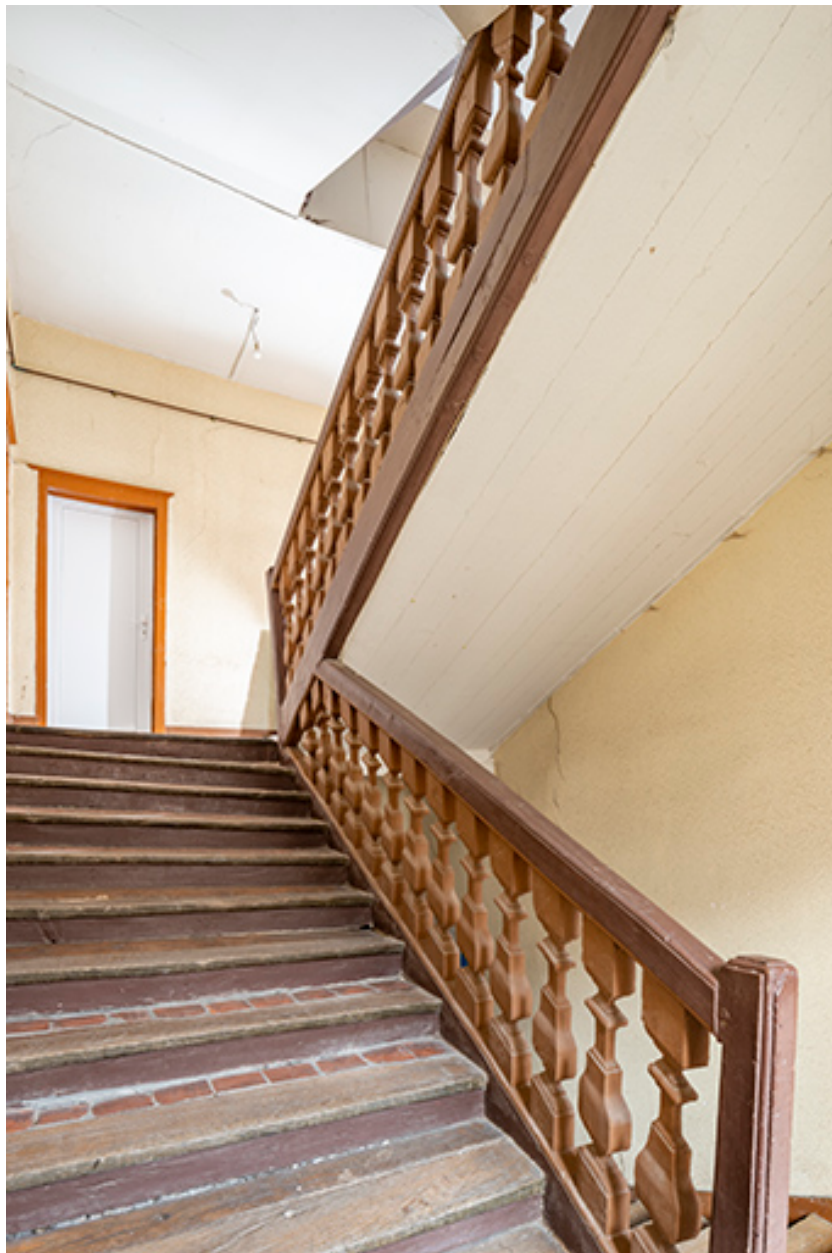
Escalier (n°3). Vue depuis le premier étage.
