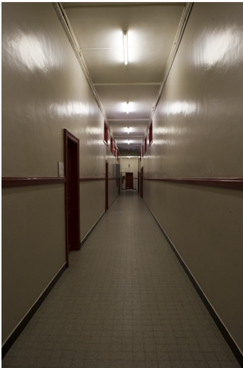
Bâtiment B. Vue couloir.
