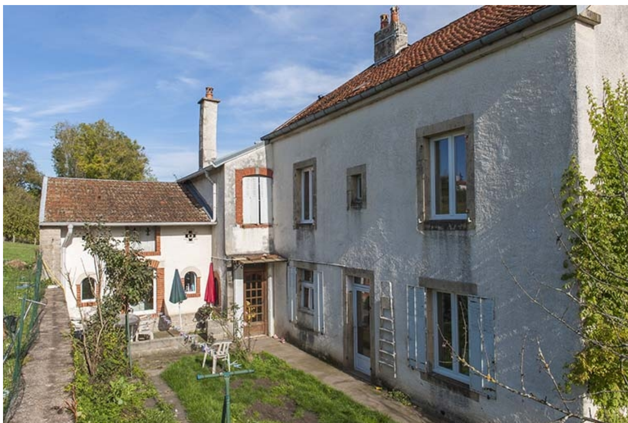
Façade postérieure et remise.
