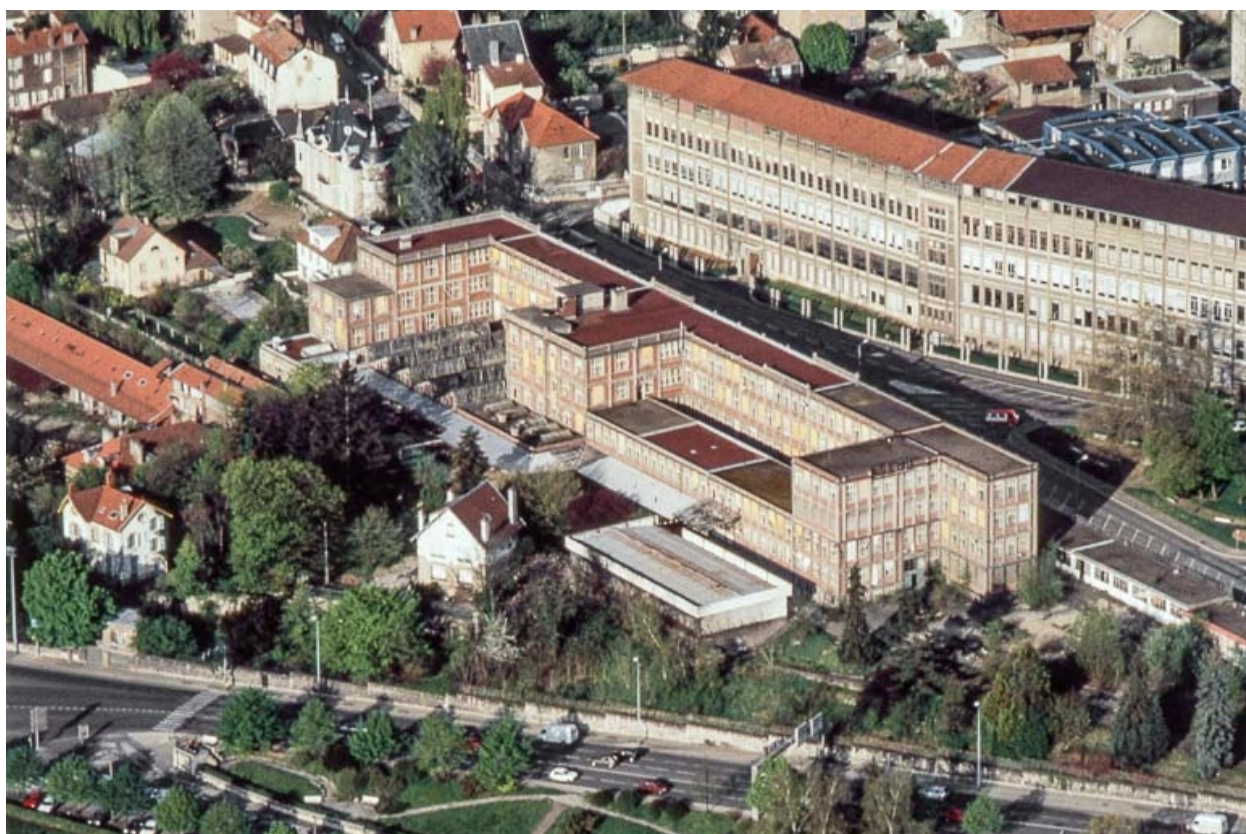
Vue aérienne de l'usine, depuis l'est.
