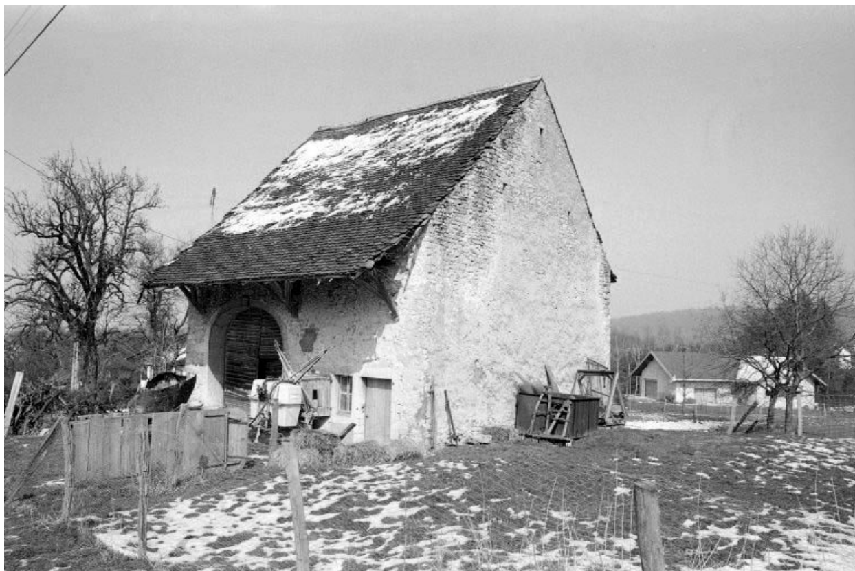
Edifice agricole à Montbouton.
