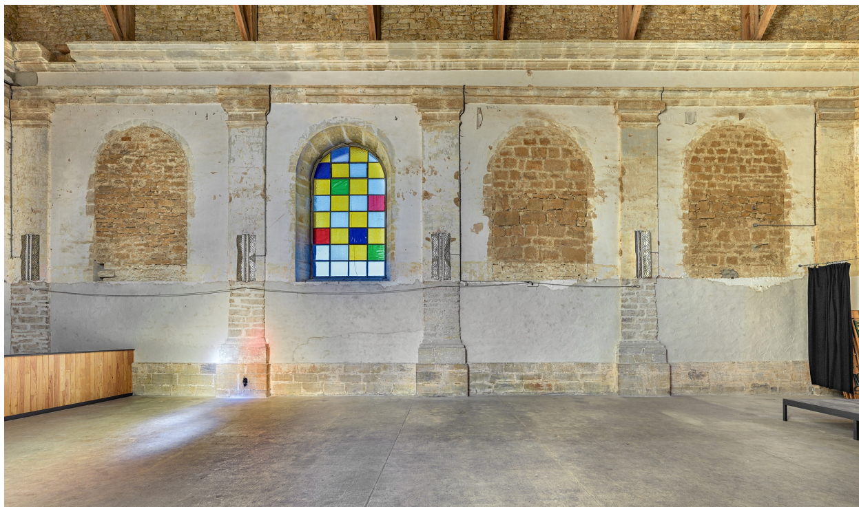
Mur latéral de la nef.
