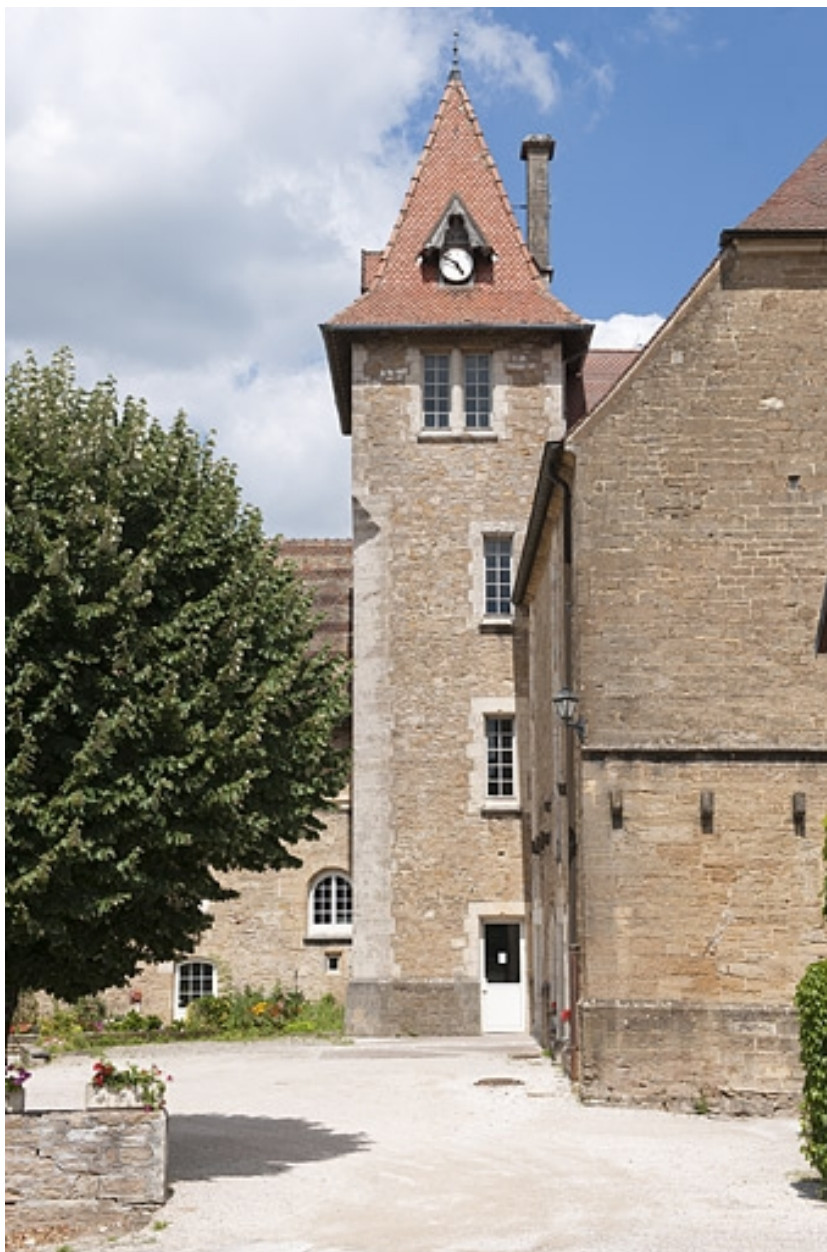
Bâtiment (C), vue de la tour d'escalier.
