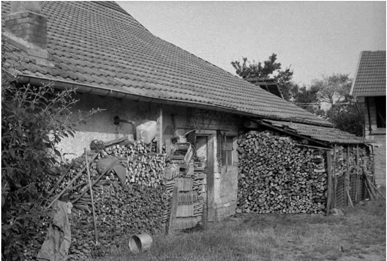
Façade latérale droite.
