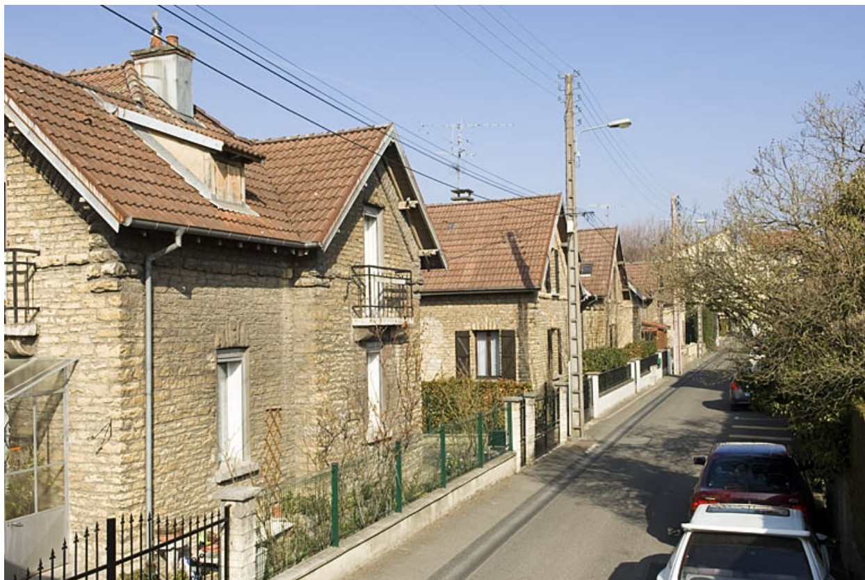
Façades antérieures sur la rue des Fleurs.
