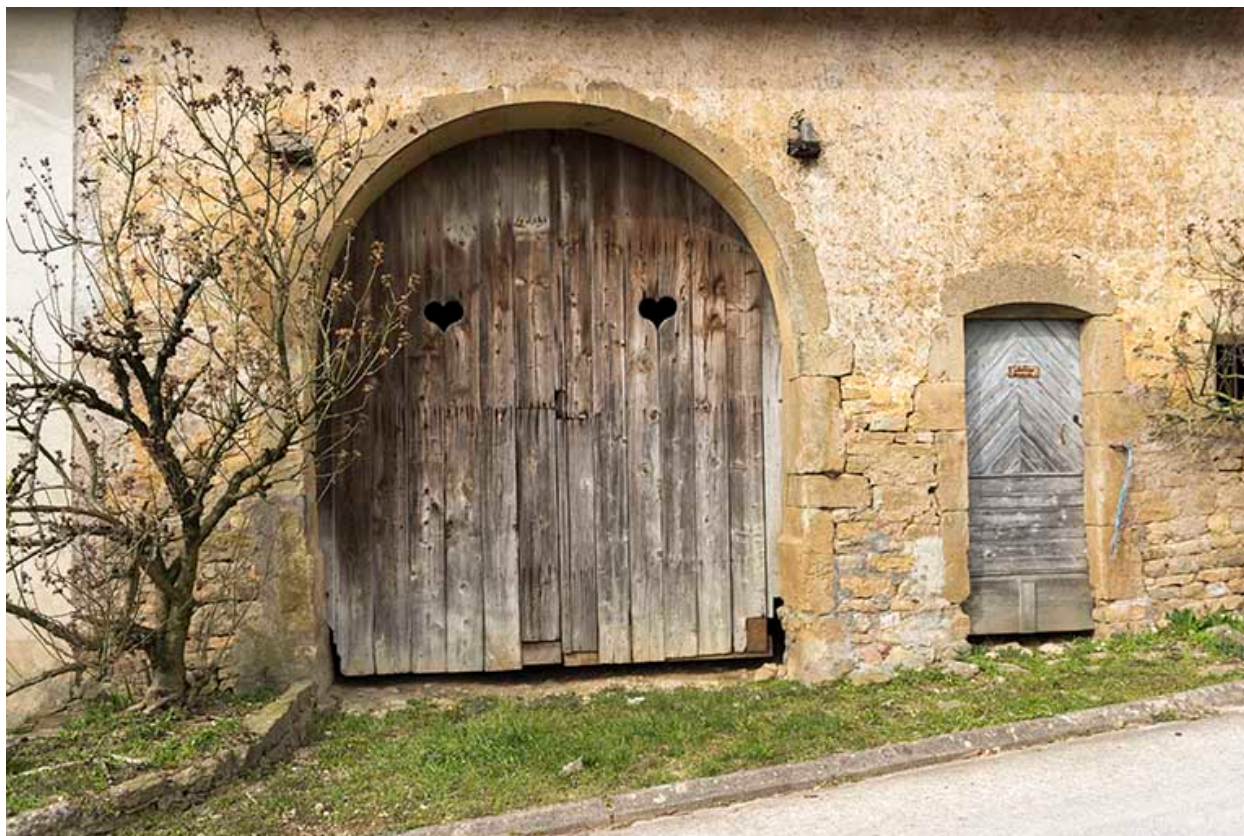
Entrée d'une grange à Aisey.
