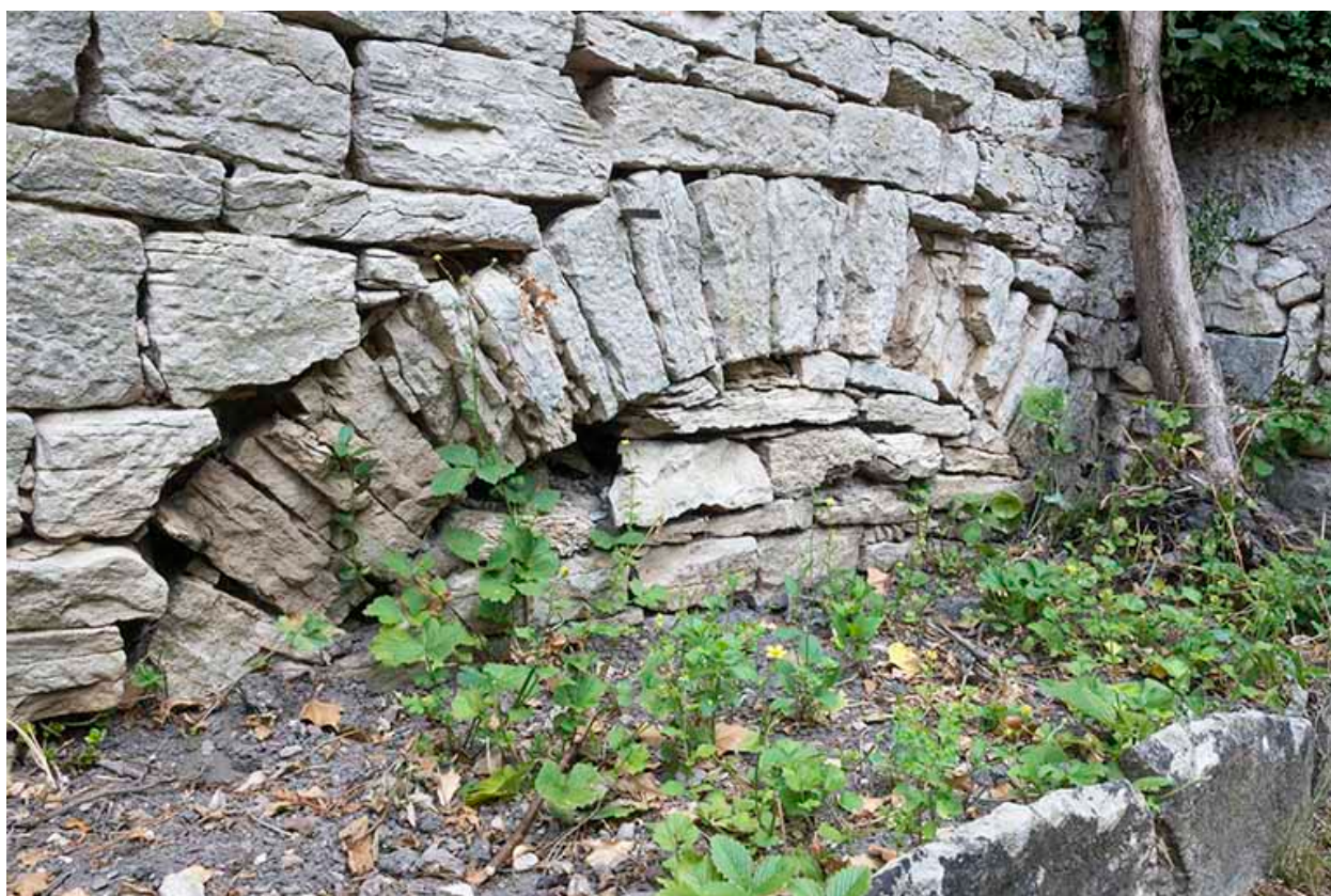
Détail de la maçonnerie d'une voûte.
