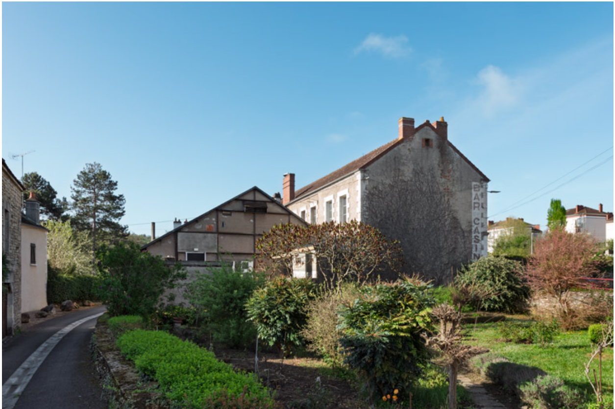
Façade postérieure et salle 1, depuis le nord-est.
