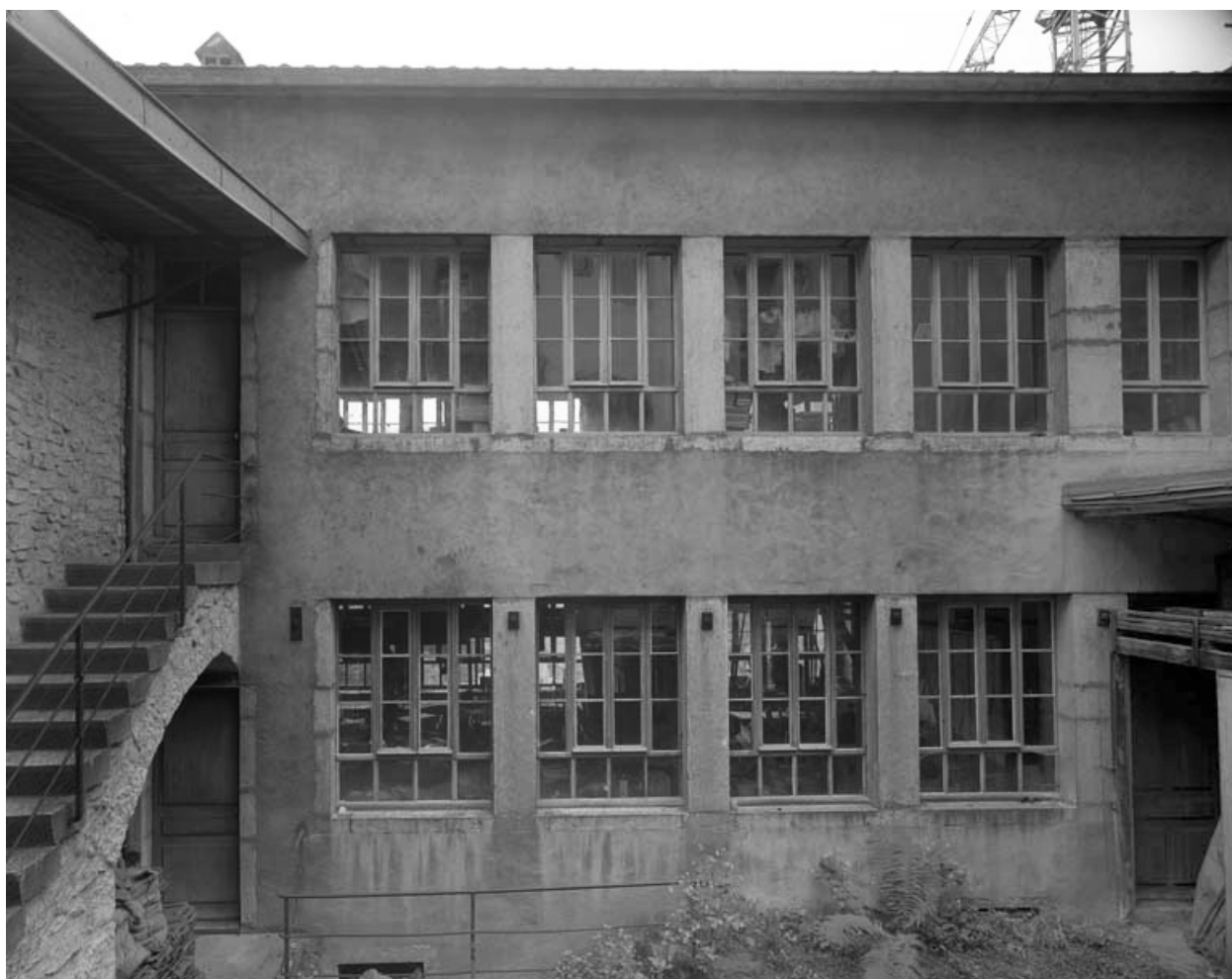
Façade antérieure de l'usine.
