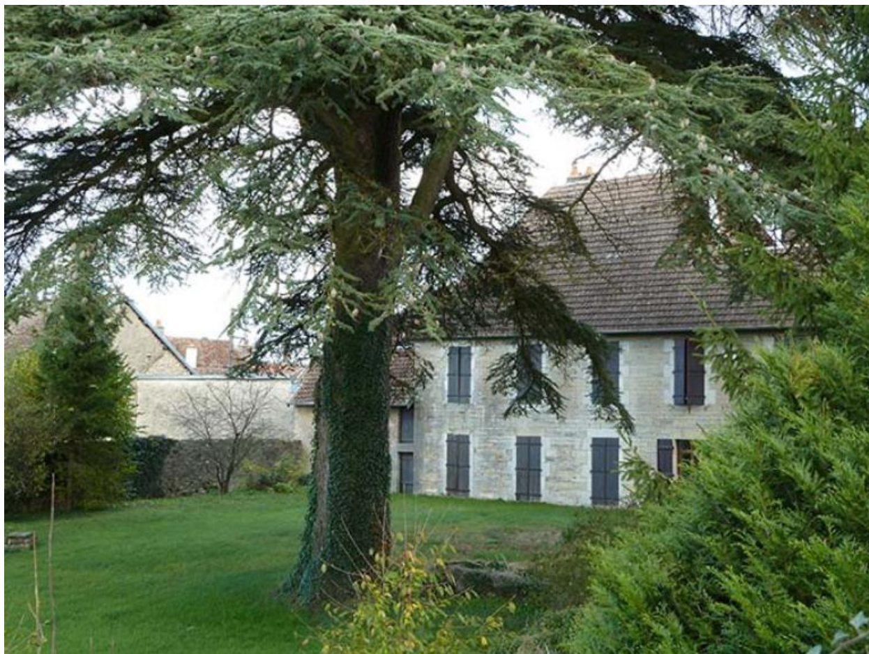
Façade postérieure (ouest)
