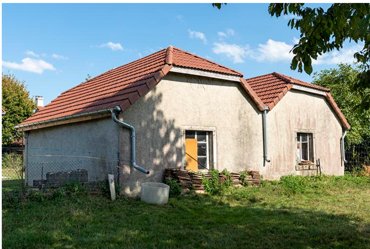
Forges : façade postérieure, de trois quarts gauche.
