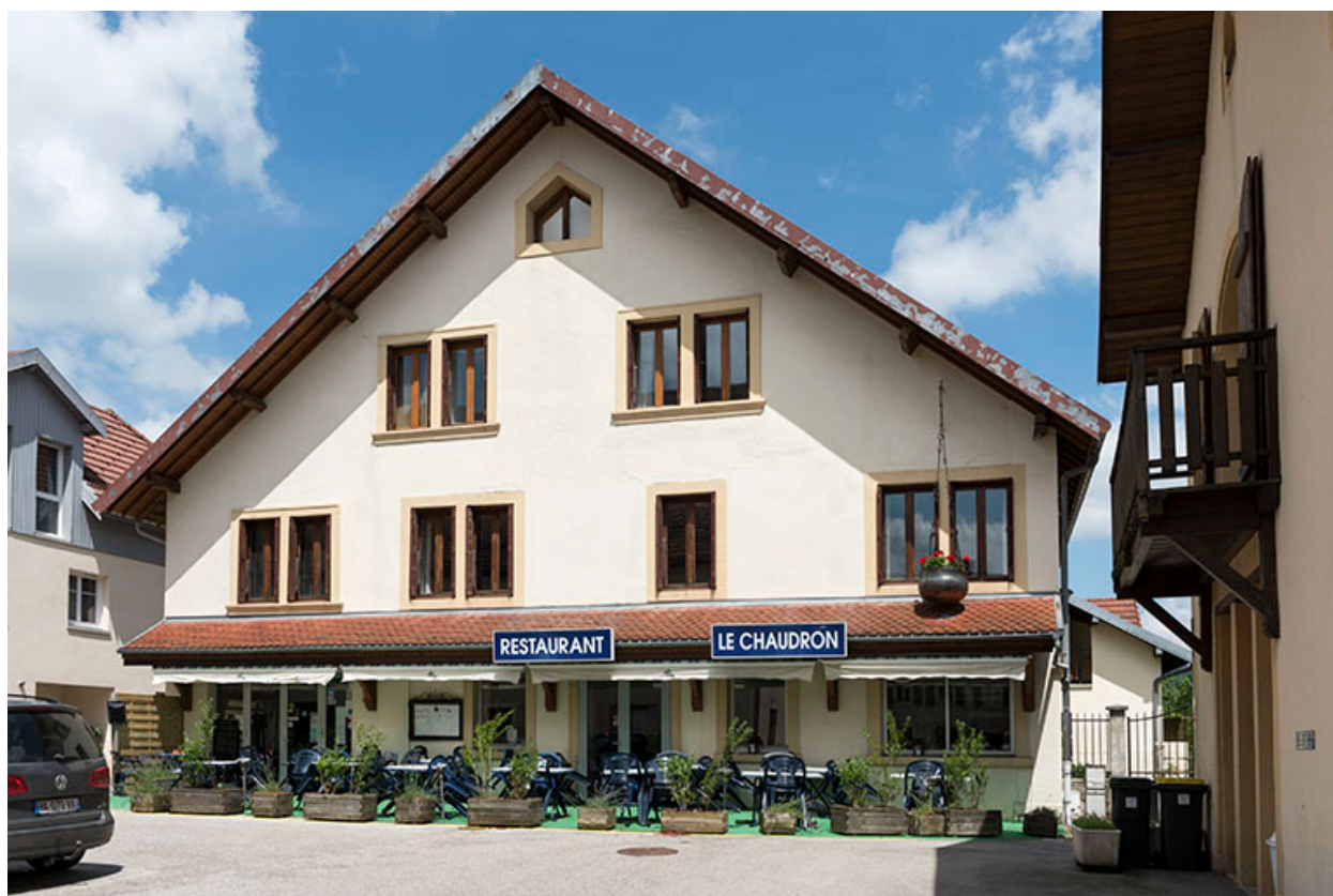
Ancienne ferme et atelier Seguin.
