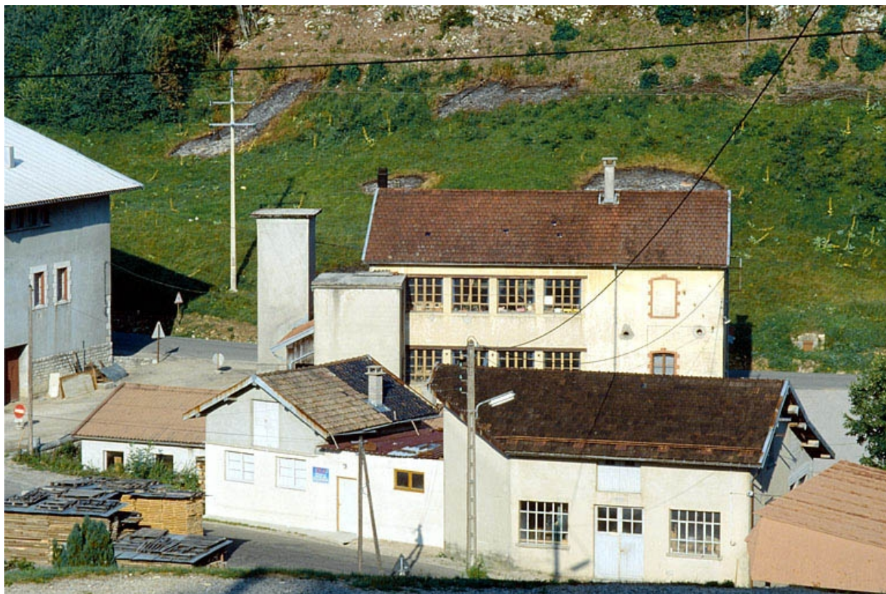
Façade postérieure vue de trois quarts droite.
