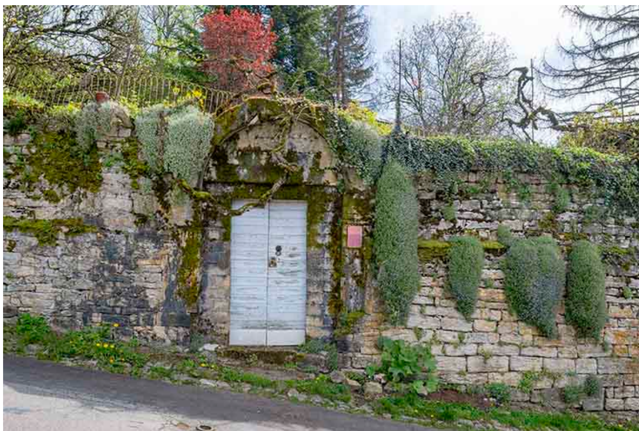
Porte d'entrée rue des Chambenoz.
