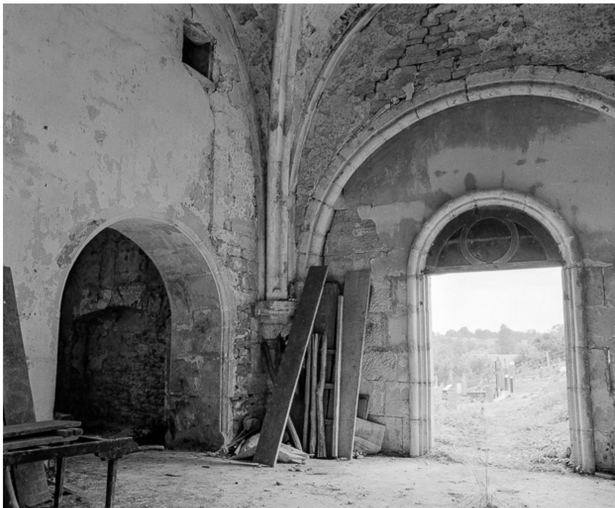
Intérieur : mur antérieur et latéral droit.
