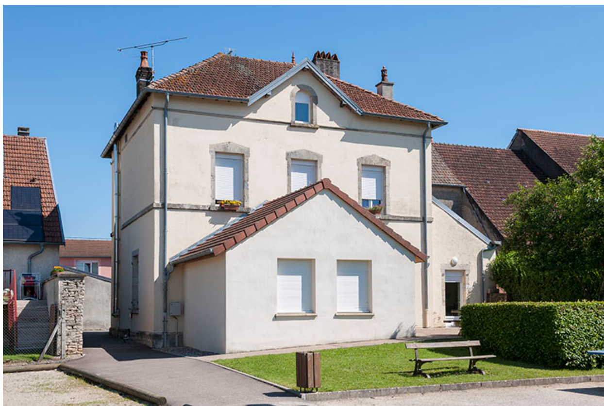
Façade postérieure avec l'agrandissement contemporain.
