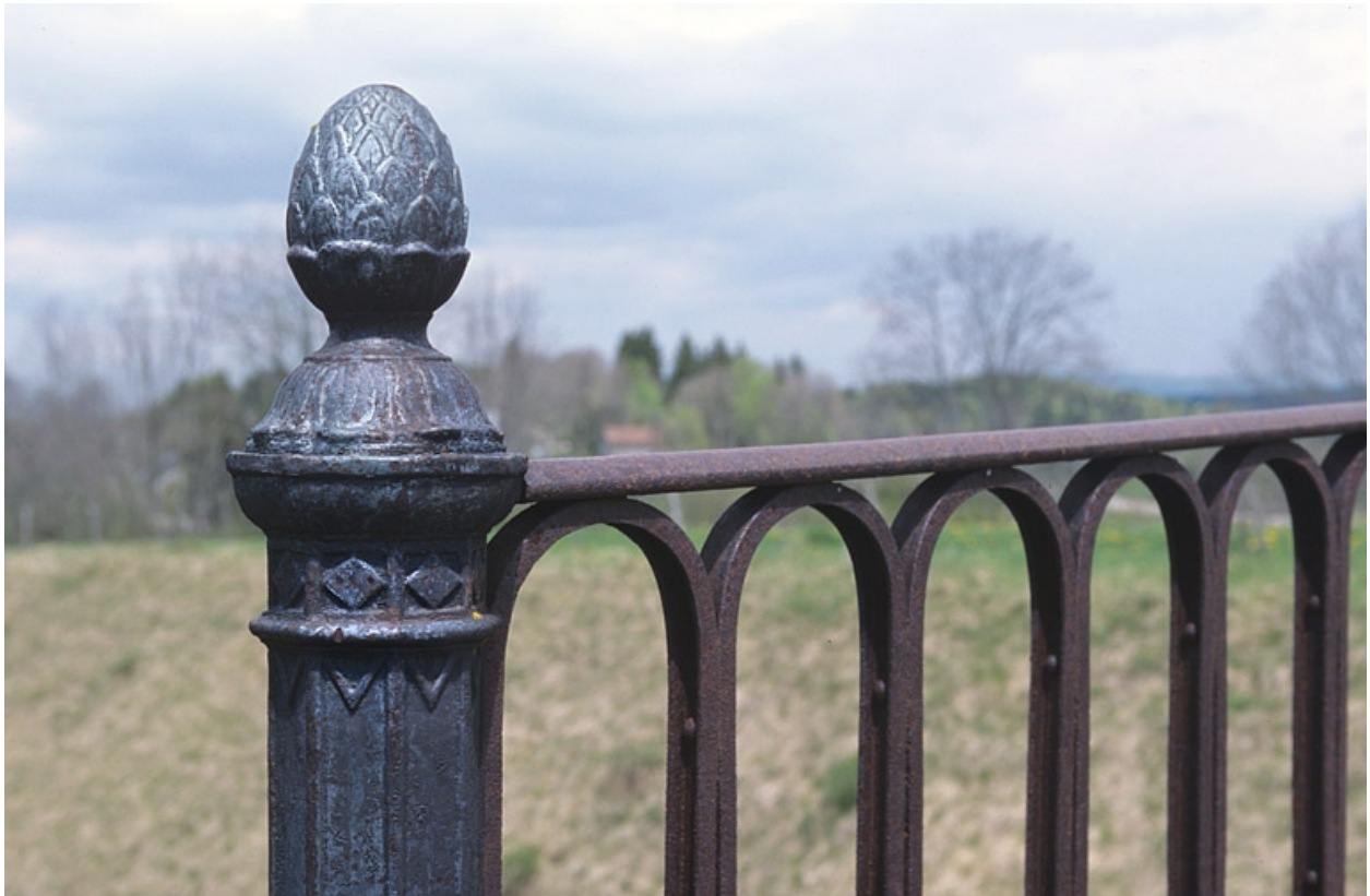
Motif d'amortissement d'un potelet du garde-corps.
