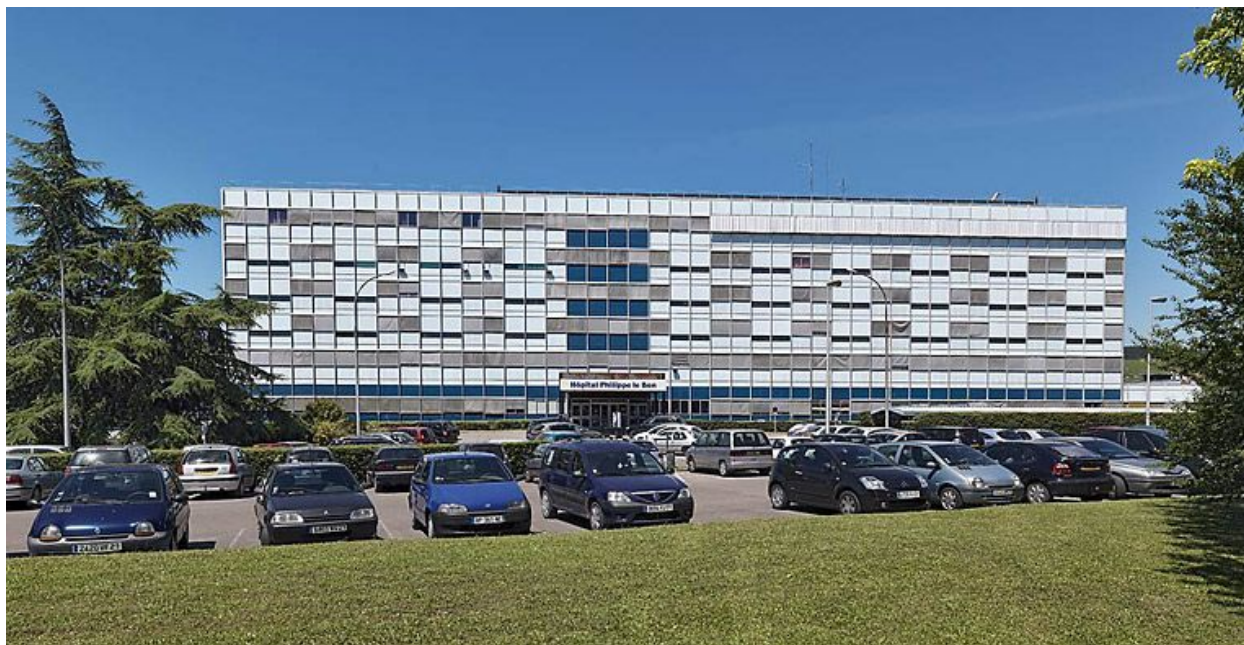
Bâtiment principal, façade.
