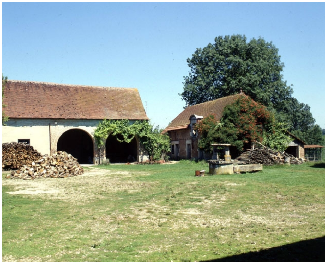
Bâtiments d'exploitation autour de la cour et puits.
