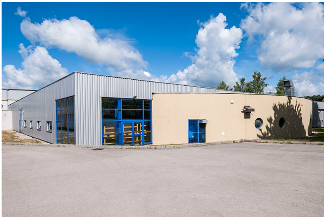
Ateliers, façade postérieure avec extension.
