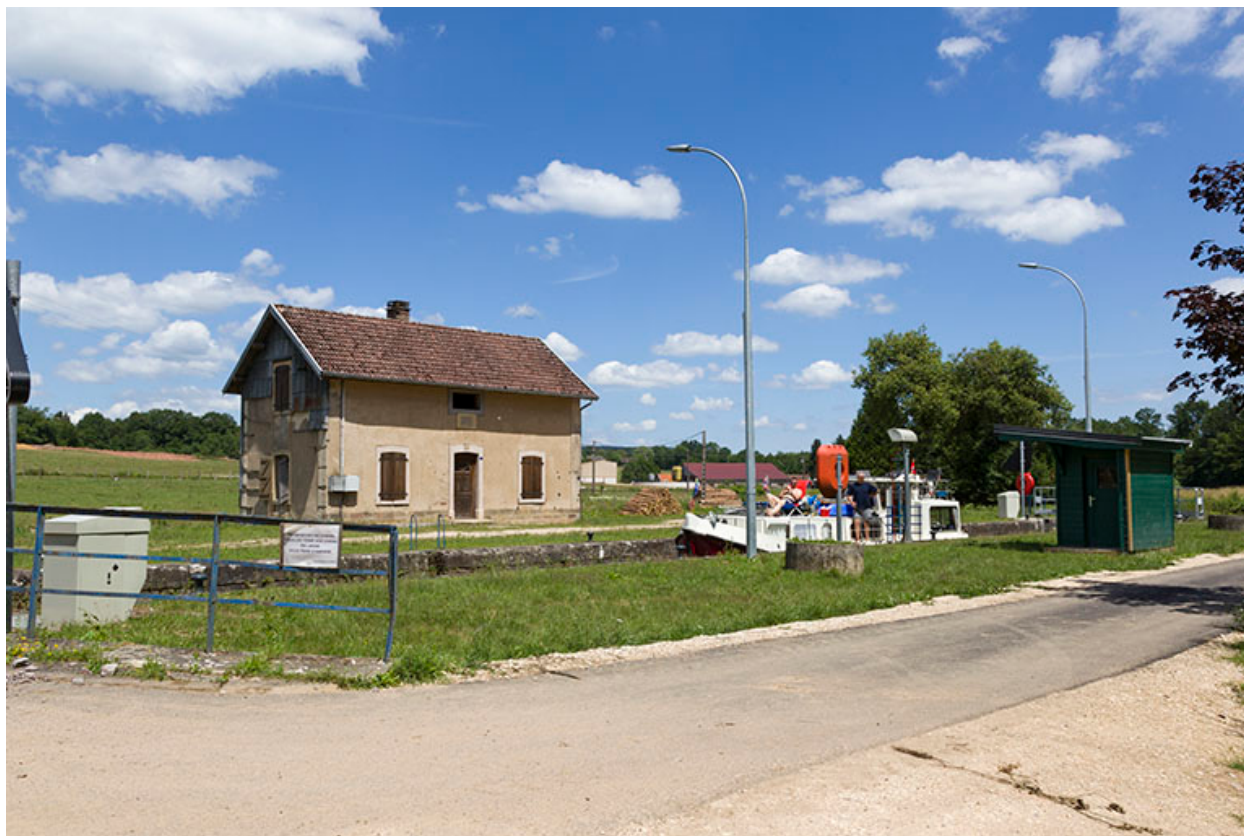
Le site d'écluse.
