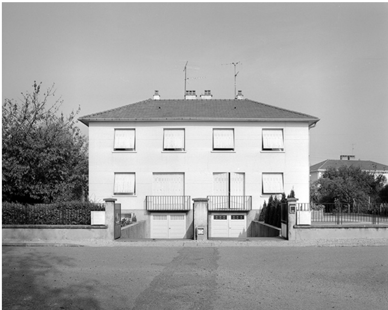
Façade antérieure, vue de face.
