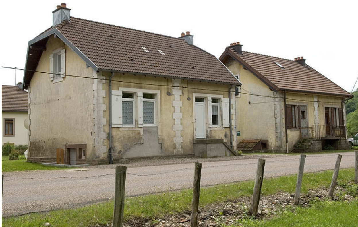
Deux logements doubles de la cité ouvrière.
