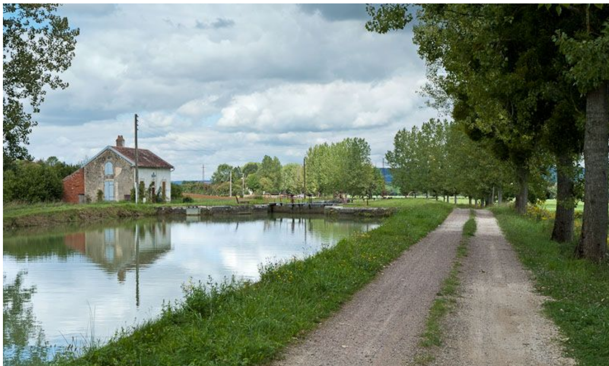
Vue du site d'écluse depuis l'amont.
