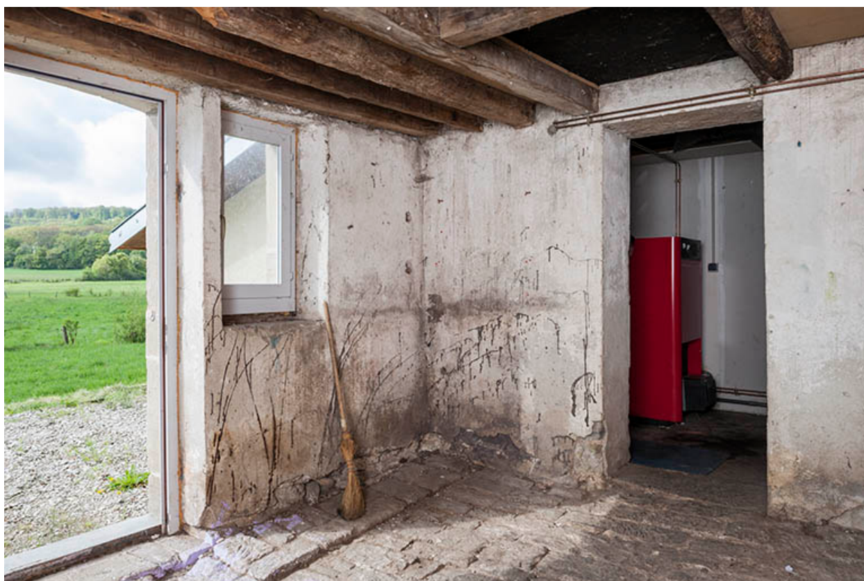
Cave en déblai.
