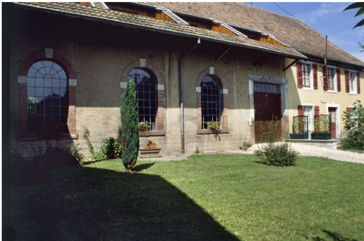
Façade de l'atelier mécanique.
