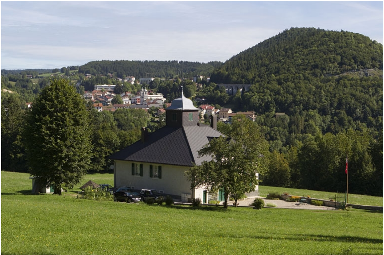
Vue d'ensemble, depuis l'ouest.
