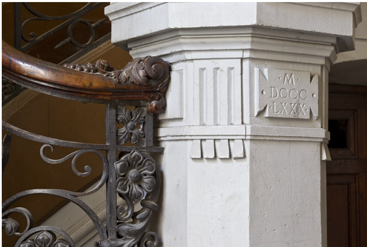
détail de la date (1890).
