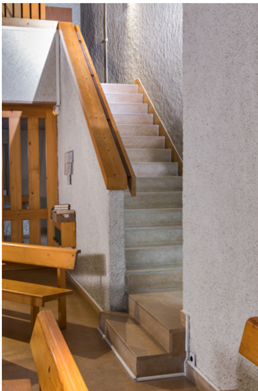
Vue de l'escalier de la tribune.
