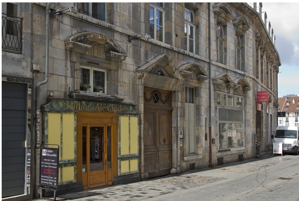
Façade antérieure : détail de la partie gauche.
