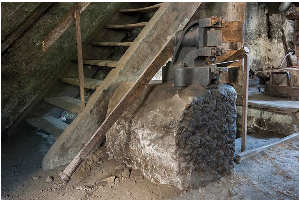
Atelier de mécanique. Poinçonneuse.
