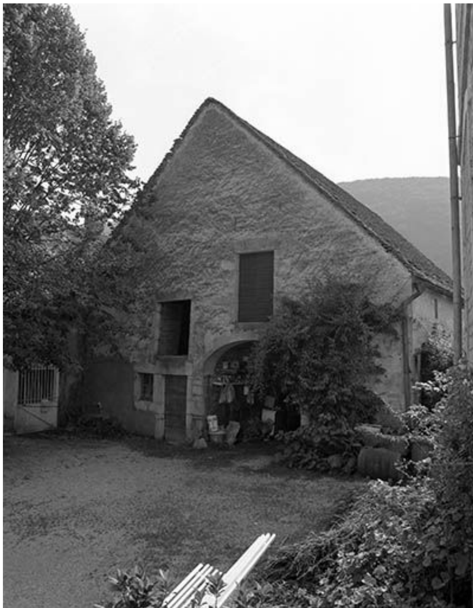
Façade antérieure des parties agricoles.
