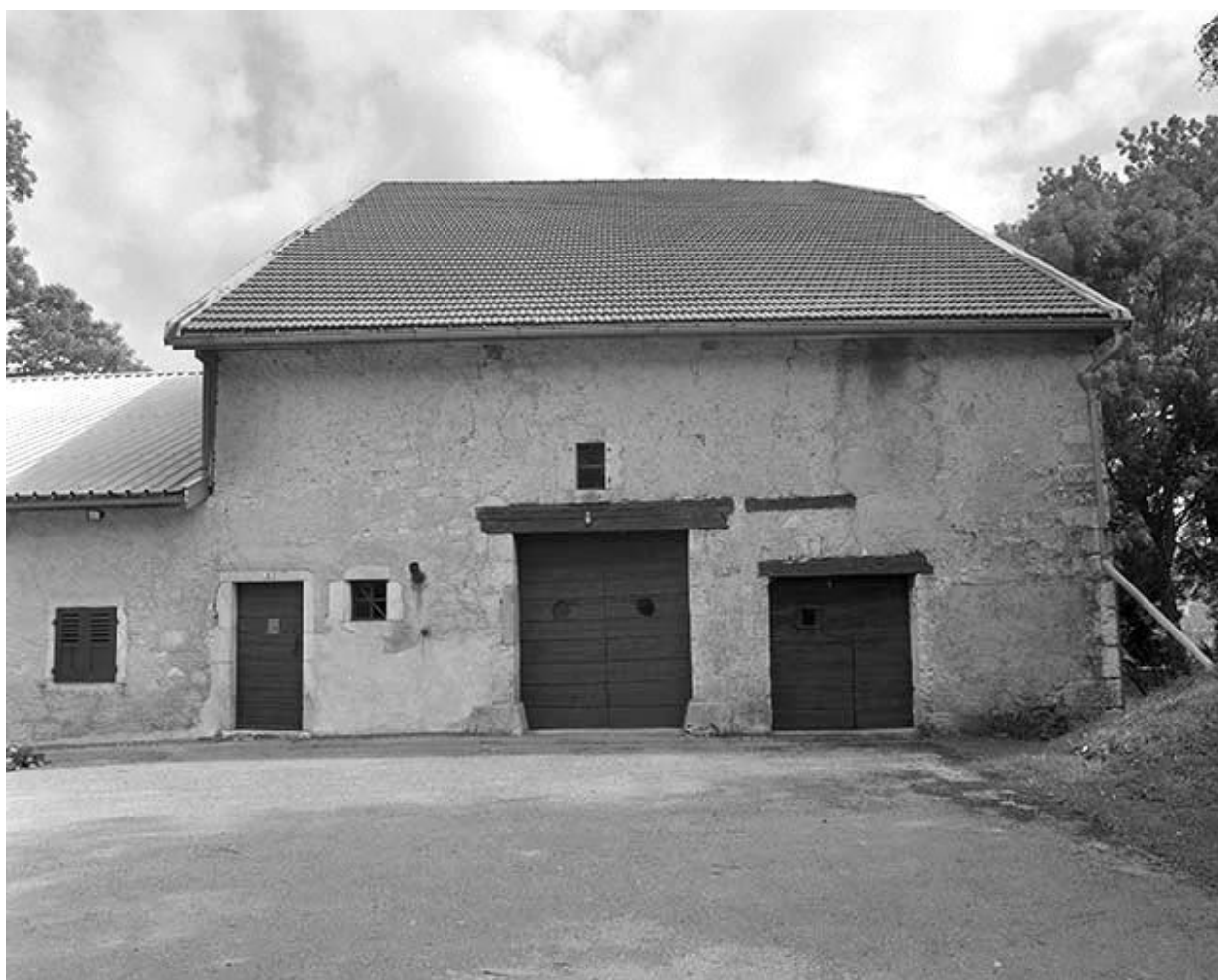
Façade postérieure de la ferme de gauche.
