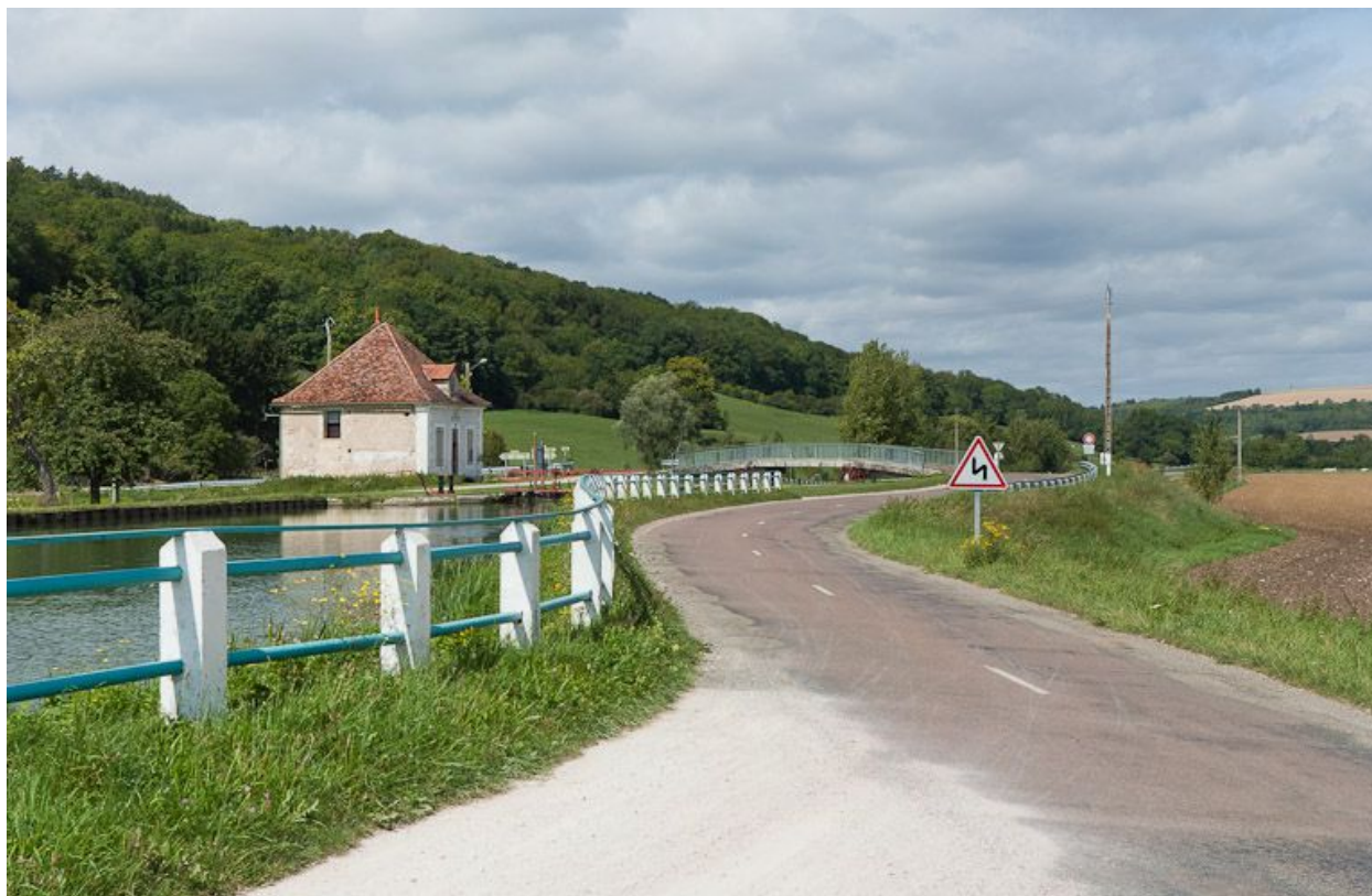
Vue du site d'écluse depuis la route.
