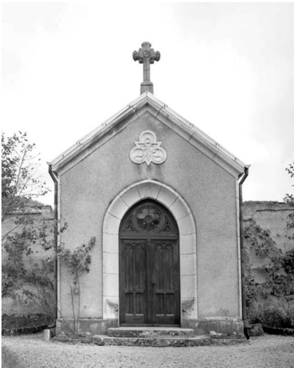
Chapelle adossée au mur d'enclos nord.
