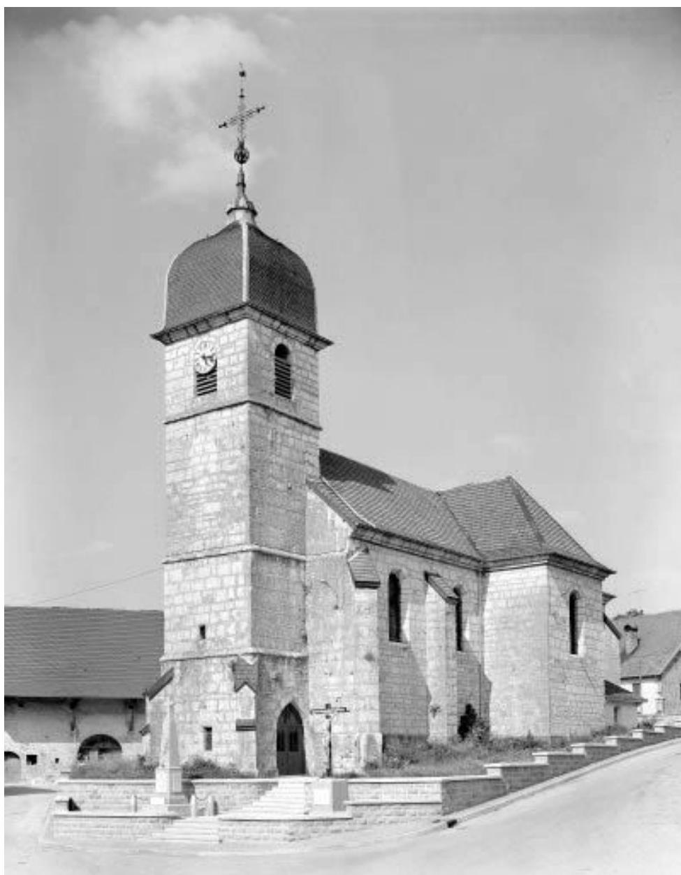
Facades antérieure et latérale droite.
