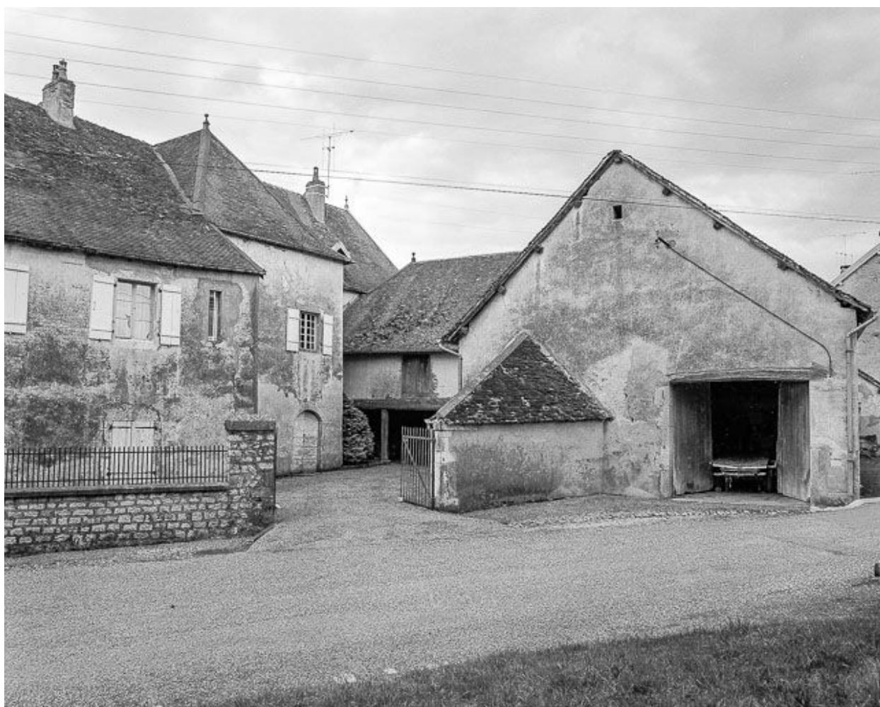
Façade postérieure : cour et remises.
