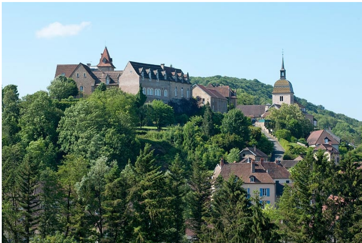
Vue générale depuis le nord-ouest.
