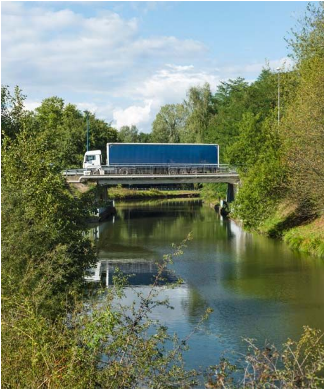
Vue d'ensemble du pont.
