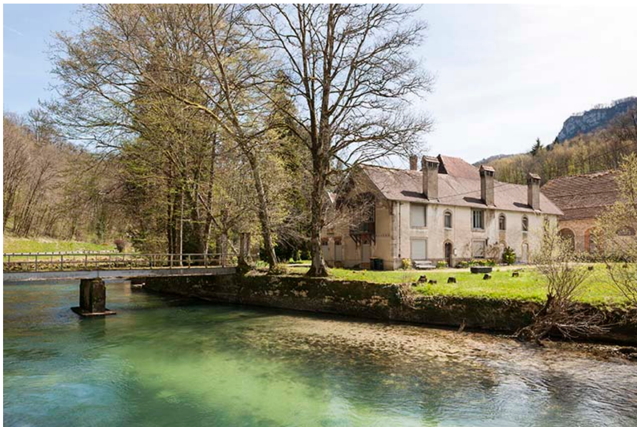
Logement patronal depuis le nord-ouest.
